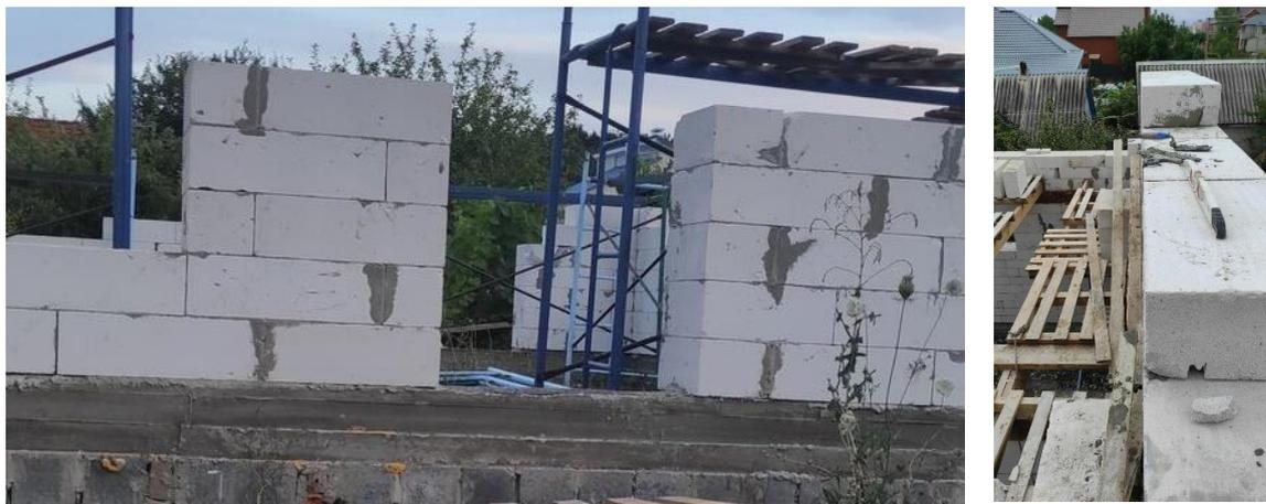
Рисунок 5.8 – Возведение наружного ограждения из газобетонных блоков
